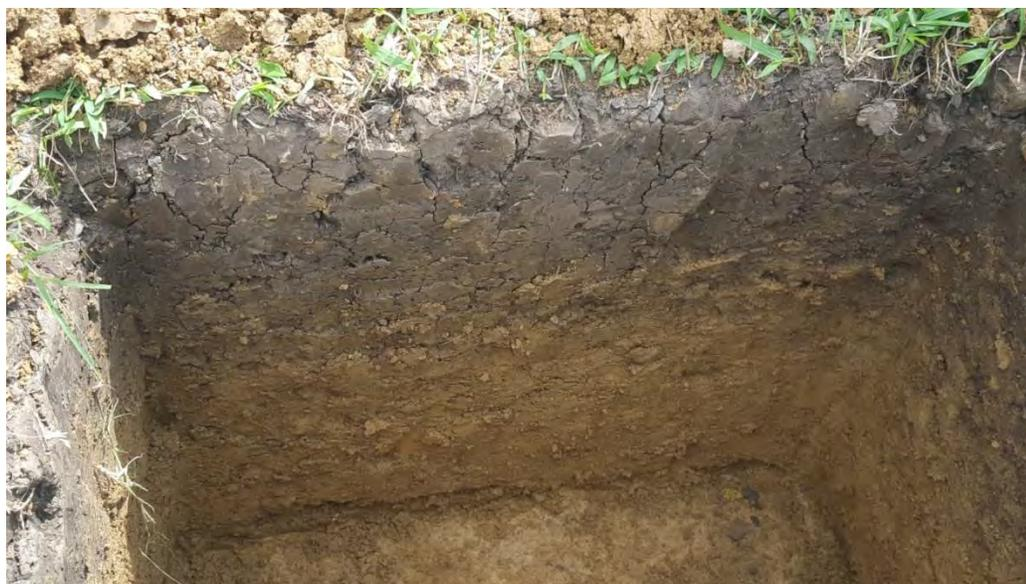
*Figura 4: Calicata para determinar horizonte del terreno en estudio*
